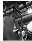
検知棒（赤色）を使用することで 高所や遠所、狭所も測定できます。
